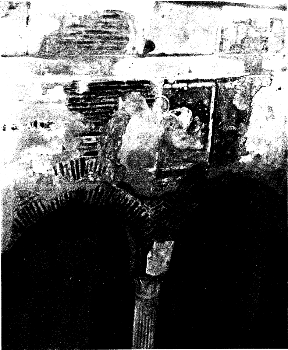
Fig. 13 - Brescia, S. Salvatore: La muratura degli archi e della parete nord della navata centrale.
