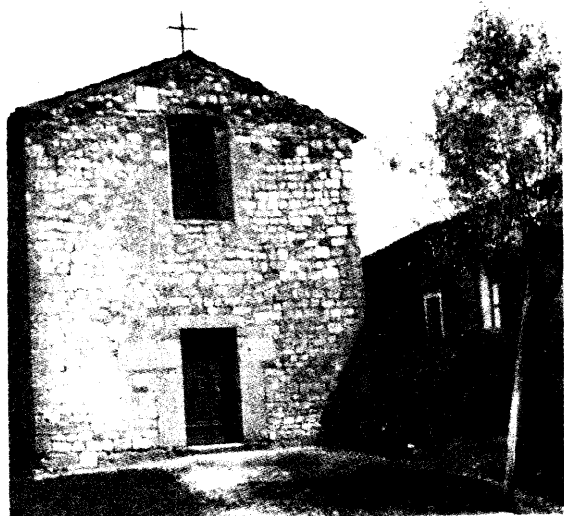
Fig. 104. - Lonato, S. Cipriano: Facciata.
